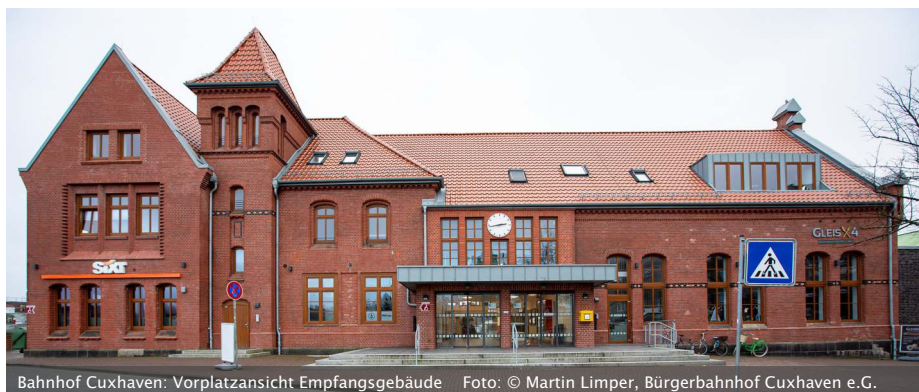
Bahnhof Cuxhaven: Vorplatzansicht Empfangsgebäude Foto: © Martin Limper, Bürgerbahnhof Cuxhaven e.G.
