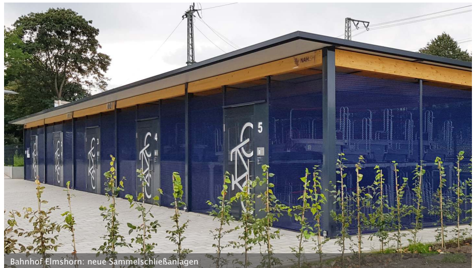
Bahnhof Elmshorn: neue Sammelschließanlagen
