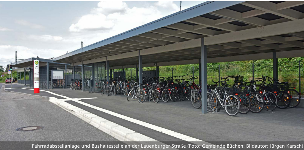
Fahrradabstellanlage und Bushaltestelle an der Lauenburger Straße (Foto: Gemeinde Büchen; Bildautor: Jürgen Karsch)
