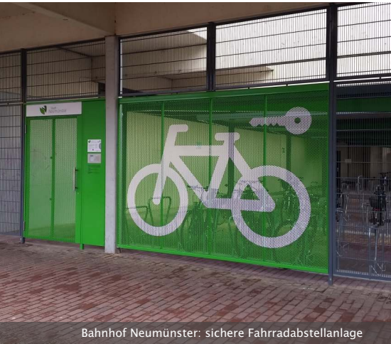
Bahnhof Neumünster: sichere Fahrradabstellanlage
