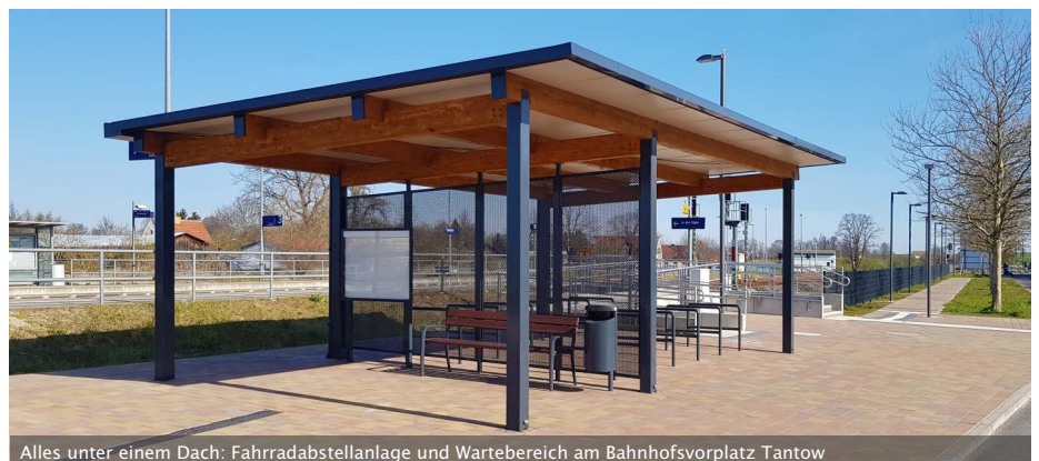
Alles unter einem Dach: Fahrradabstellanlage und Wartebereich am Bahnhofsvorplatz Tantow
